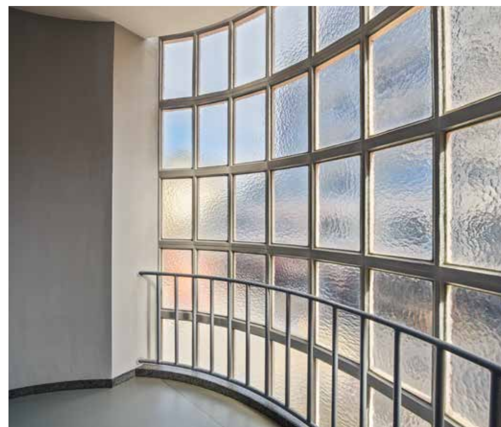
Das gerundete Treppenhaus zur Bruchstrasse mit den filigranen Betongitterfenstern. Sie sind von unersetzbarem Wert, ihre Herstellungstechnik wird heute nicht mehr beherrscht, links: 31.3.16, 14:41 Uhr, unten: 10.10.17, 10:36 Uhr
