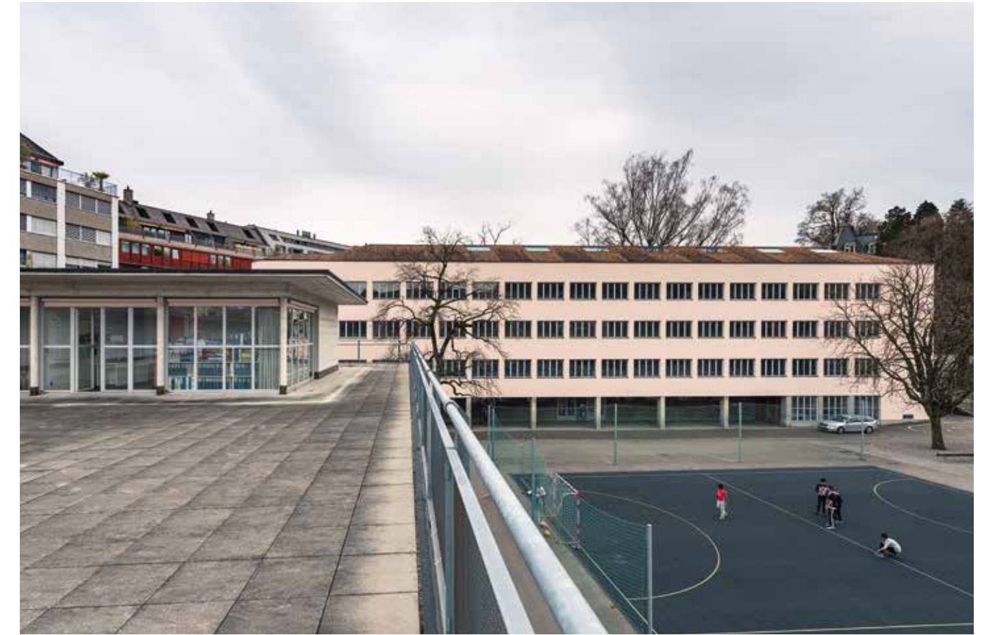
Blick von der Dachterrasse der Turnhalle auf den Innenhof. Im Glaspavillon befand sich früher die Waschküche. Heute ist auch die Musikschule ins Gebäude der Turnhalle integriert, 31.3.16, 14:56 Uhr
