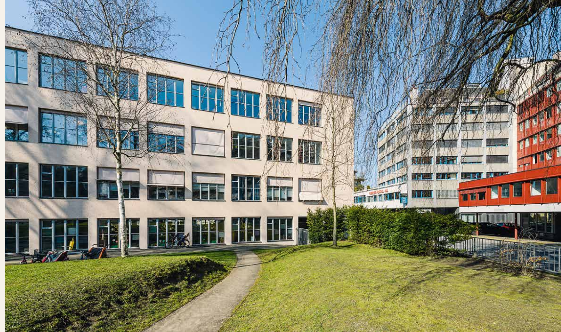
Südfassade des Dula-Schulhauses. Sie wird durch die annähernd quadratischen Fenster rasterartig aufgelöst. Der Fensteranteil der Fassade ist für die damalige Zeit sehr hoch und lehnt sich an die typischen gläsernen Fassaden des Neuen Bauens an. Dahinter befinden sich die Klassenzimmer. Die neuen Materialien und Bautechniken sowie die südliche Lage ermöglichen lichtdurchflutete Zimmer, oben: 17.3.16, 14:28 Uhr, rechts: 22.4.16, 11:41 Uhr
