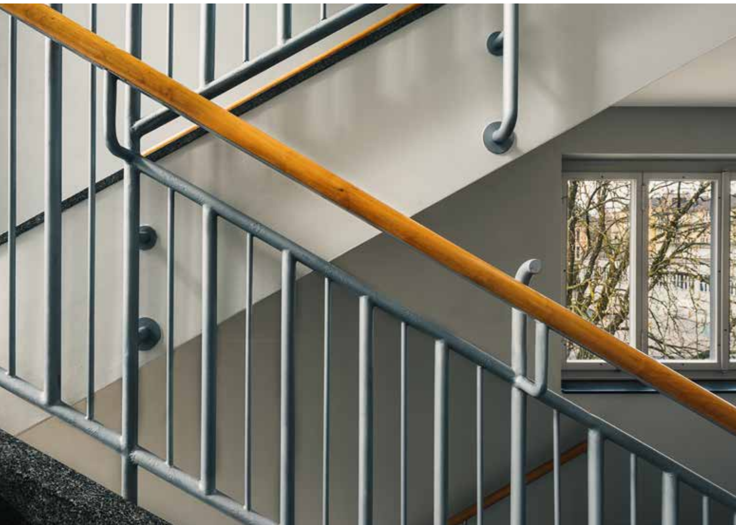
Das originale Treppengeländer konnte in seiner schönen Schlichtheit nur teilweise erhalten bleiben. Aus Sicherheitsgründen mussten zusätzliche dünne Staketten eingesetzt werden, links: 31.3.16, 14:33 Uhr, rechts: 6.4.16, 12:11 Uhr
