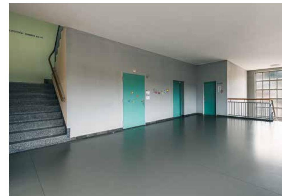
oben: Die Gänge des Schulhauses blieben auch nach der Restaurierung in ihrer Grosszügigkeit erhalten. Dafür wurden die Brandschutztüren in den Achsen der Querwände versteckt, 10.10.17, 11:02 Uhr
