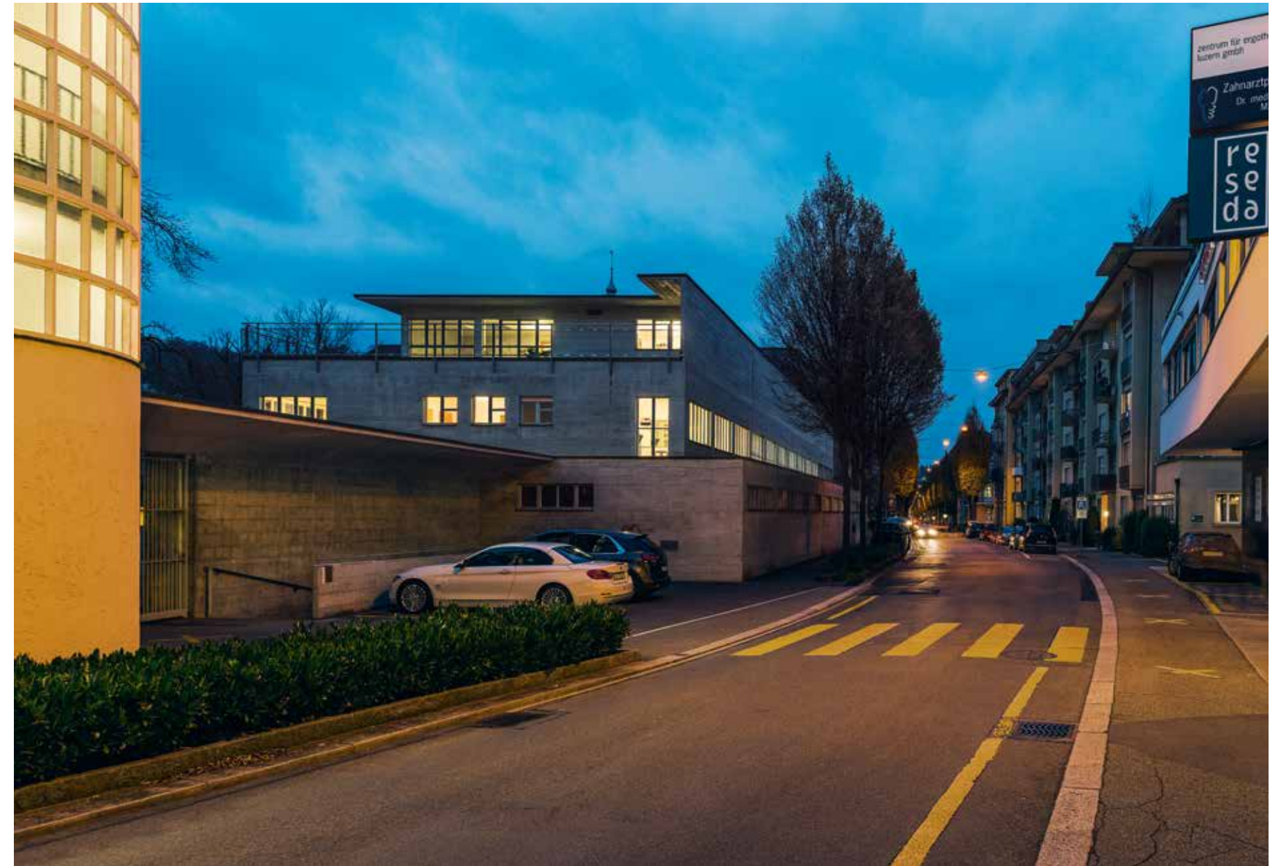
Die Turnhalle ist ein moderner Sichtbetonbau, linke Seite: 17.3.16, 14:50 Uhr, oben: 25.11.16, 18:01 Uhr
