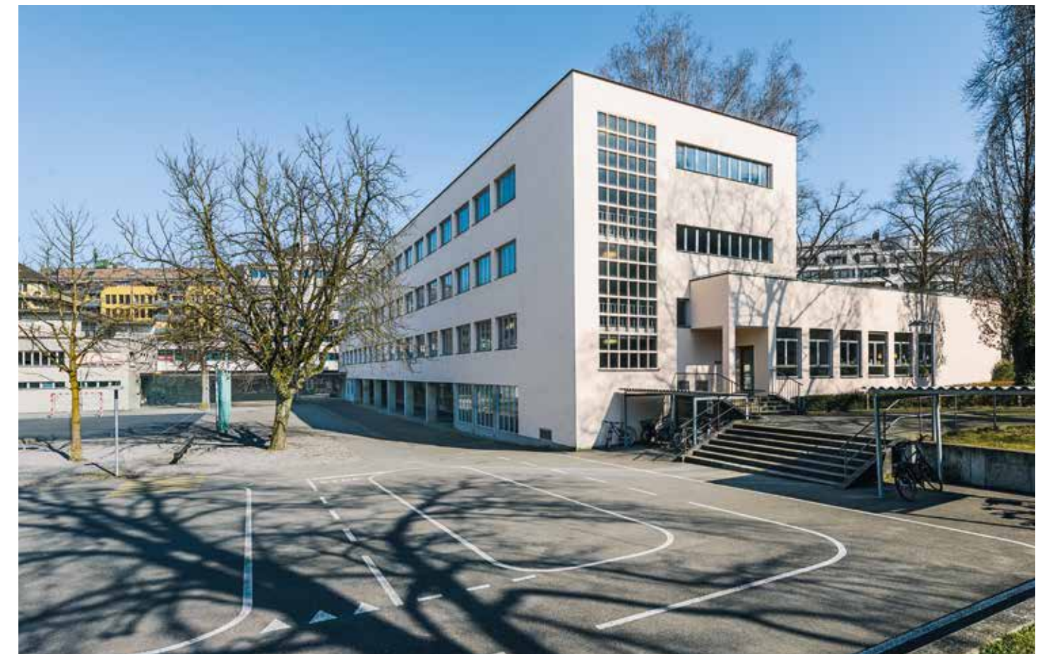
Westfassade. Der Kubus mit der Ludothek setzt sich von dem langen Gebäude- trakt des Schulhauses ab. Der Schattenwurf der Bäume auf der Fassade zeigt, je nach Jahres- und Tageszeit, ein anderes Bild, linke Seite: 25.11.16, 18:33 Uhr, oben: 17.3.16, 14:36 Uhr, unten: 17.3.16, 14:40 Uhr
