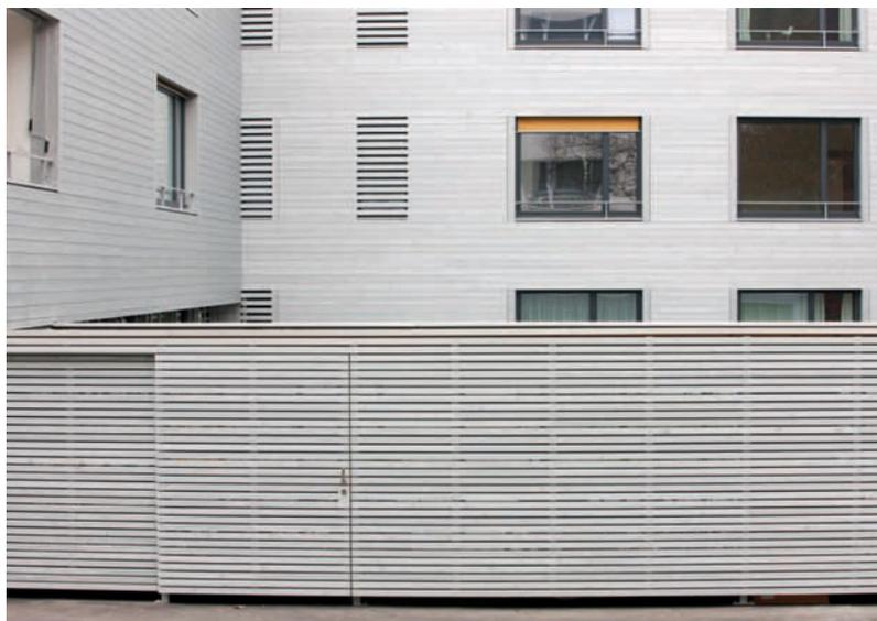
Die den Wohnbauten vorgesetzten, einen Innenhof bildenden Sichtschutzwände sind mit einer offenen Rhomboidschalung, die ebenfalls eine silbergraue Farbgebung aufweist, ausgeführt worden.
